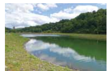
移行地域「自然に配慮されたダム」
